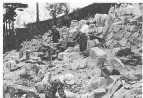
用土の敷き込み
