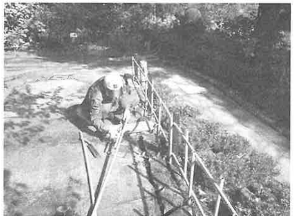
写真3 四つ目垣を作り直す作業の様子
