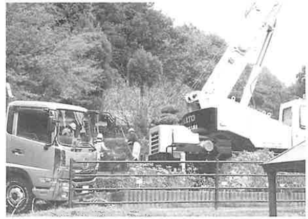
写真6 景石搬入、据付の様子
