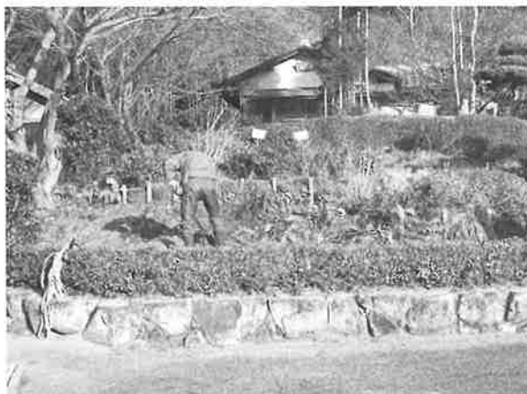
写真5 チャノキ等撤去作業の様子
