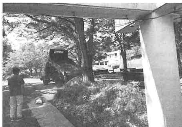
写真3 施工中 (剪定枝チップの敷き均し 同)
