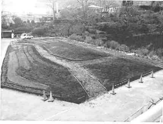
写真1 造成直後の食堂前花壇 (2020年1月)
