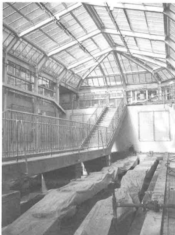
写真2 ブルーシートをかけて施工（撮影：足場撤去後）
