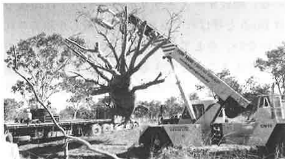
写真4 吊り上げたバオバブをトレーラーへ移送
