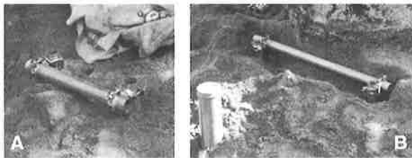
写真 16 地下支柱 (A: 根の上部に設置、B: 幹につけて設置)
