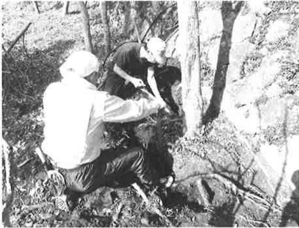
写真3 ピンクイパー根回し作業の様子
