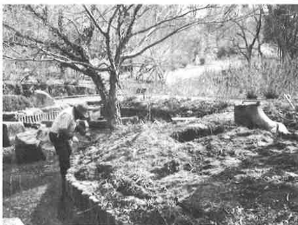
写真2 ケヤキの抜根除去（平成28年2月11日）
