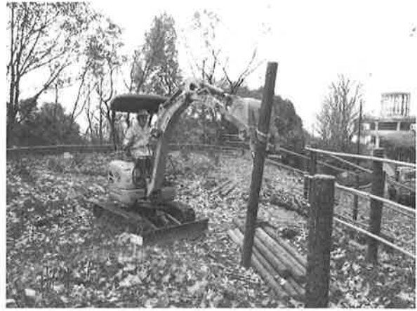
写真1 PC擬木支柱の撤去
