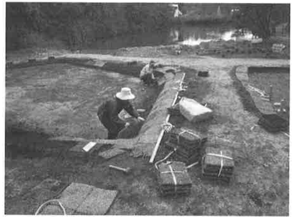
写真5 土止め用芝張り
