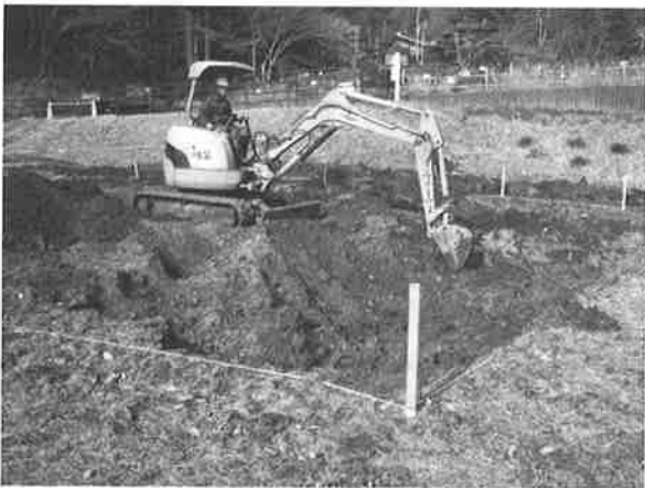
写真3 バックホウによる床堀
