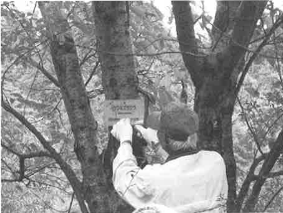
写真4 ガイドボランティアによる補修作業
