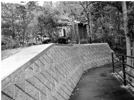
写真 11. 園路開通のおり、急傾斜ののり面には、コンクリート壁が設置された。2006 年 11 月 14 日、壁 S。
