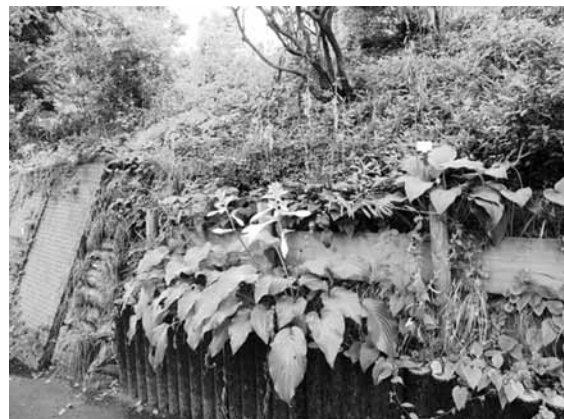
写真 6. B3 区の崖部。擬木、杉板、丸太杭などを用いて土留めをし、タマノカンザシ、オオバギボウシなどを植栽した。2009 年 8 月 17 日。
