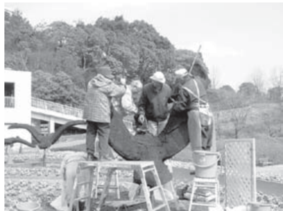
写真 6. カモの粹組みに用土を詰め込んでいるところ
