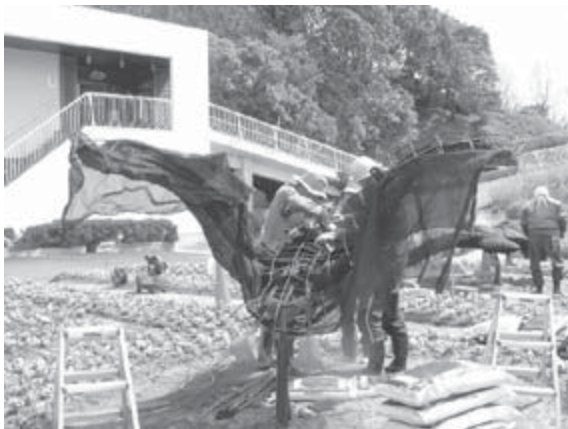
写真 5. カモの粹組みにネットを取り付けているところ
