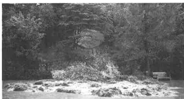
集中豪雨による土砂崩れ(芝生広場周辺)
