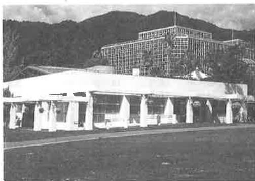
写真1 新ペゴニア温室の外観
