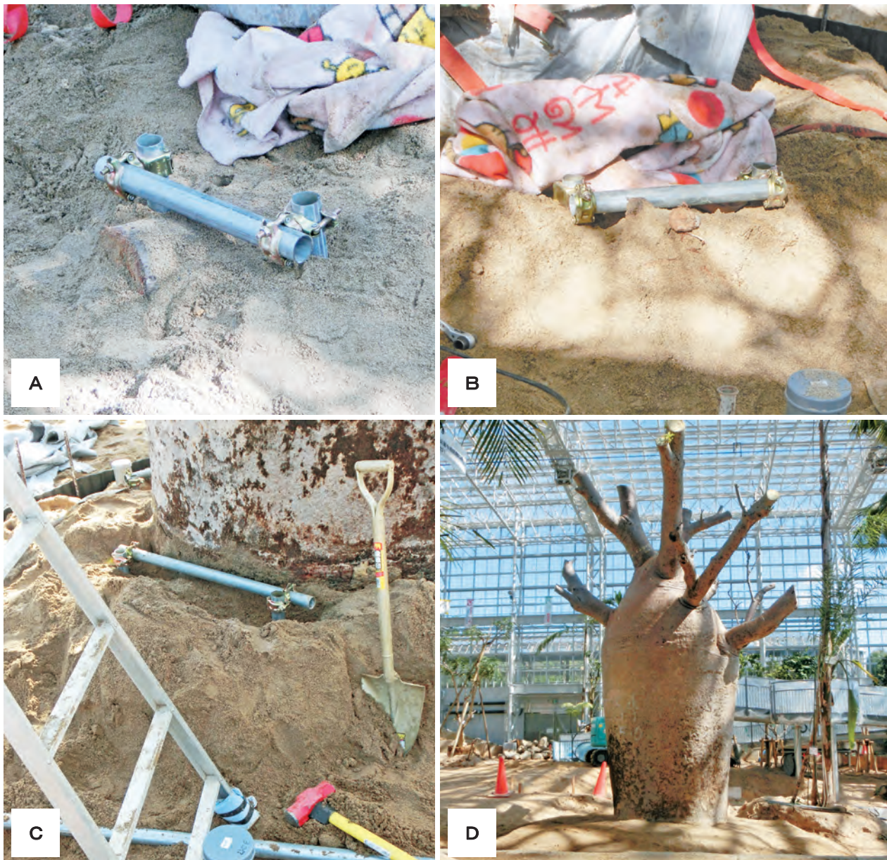
図 17. 地下支柱の設置・盛り土 A: 根を押さえる支柱（北側）。B: 根を押さえる支柱（西側）。C: 幹を押さえる支柱（東側）。D: 盛り土をした様子。
