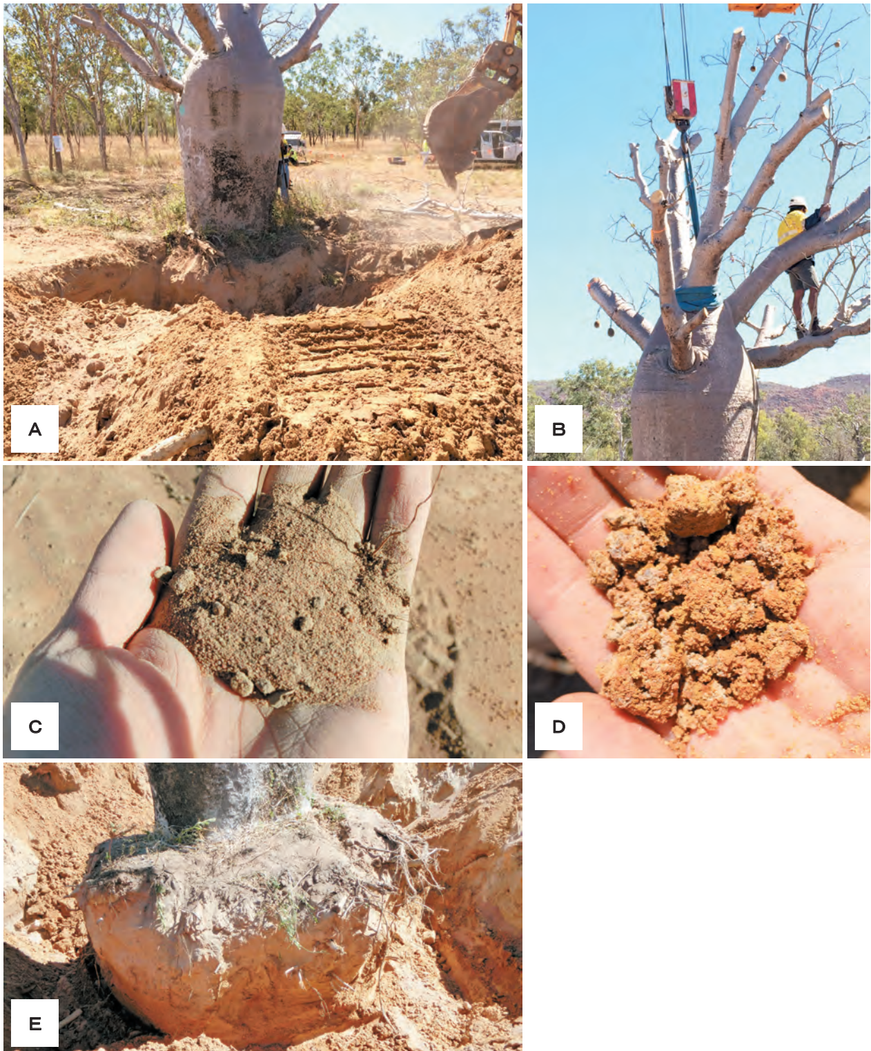
図 6. 周囲の土掘り A: バックホウによる土掘り. B: 転倒防止のソフトスリング. C: 浅い層のサラサラとした土. D: 深い層の粘土質の土. E: 土掘りを完了した根周り.
