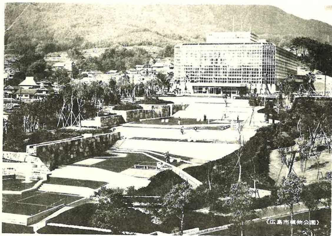
写真は広島郊外に立つ広島市植物公園です。 敷地造成、大温室から造園工事の一切を当社が施工いたしました。
