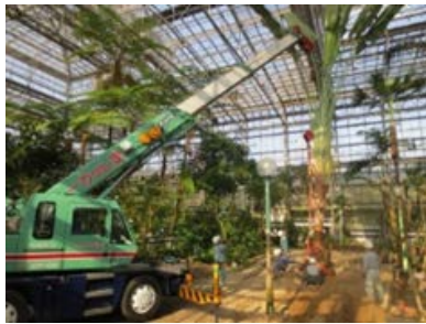
建築工事前の造園工事
