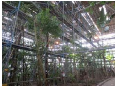
建築工事中の植物の様子
