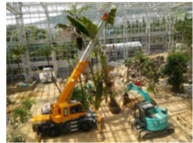
建築工事後の造園工事
